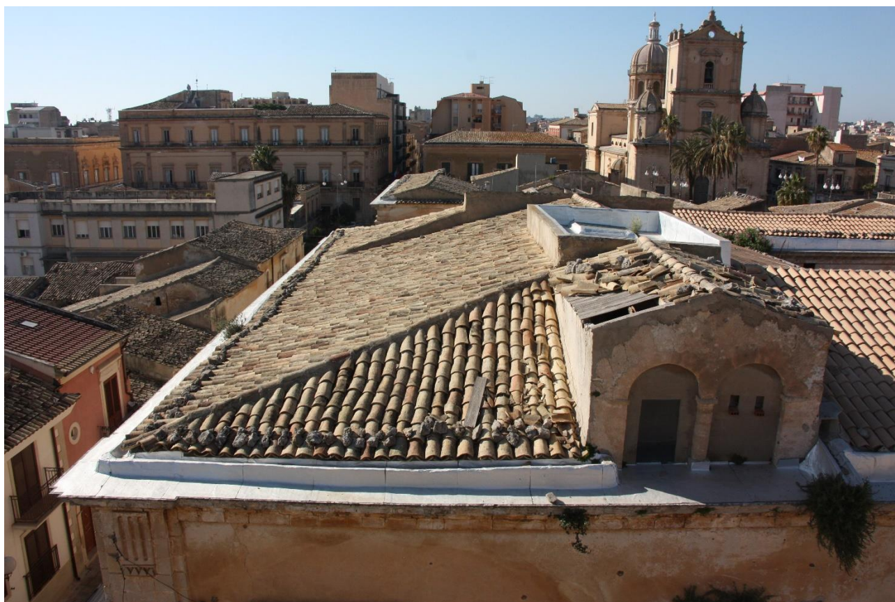
Figura 5 - Copertura a tetto del Palazzo e abbaino prospiciente alla Via Marsala
