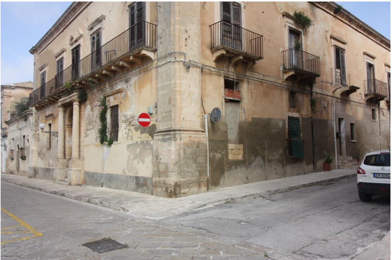
Figura 2 - Prospetto d'angolo su Via Marsala
