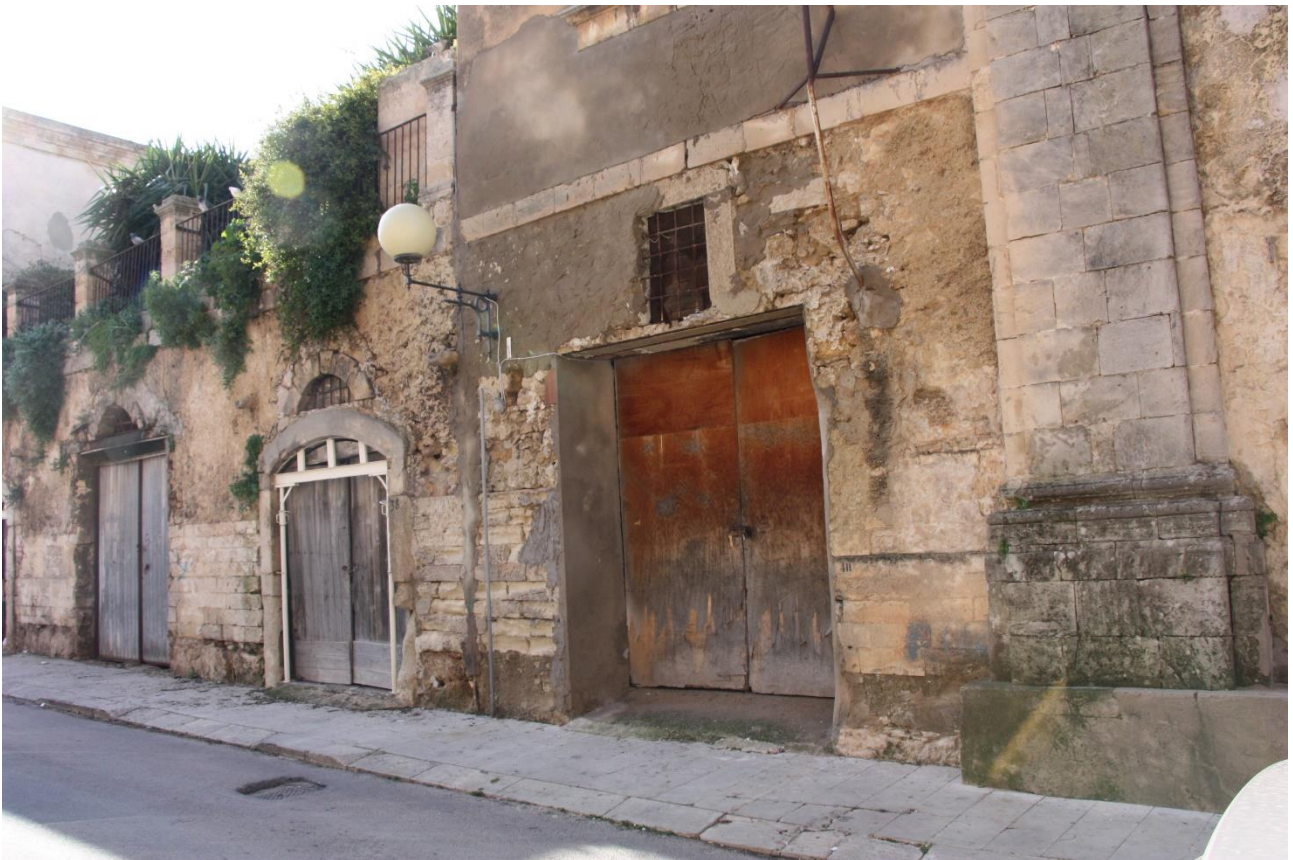
Figura 3 - Prospetto su Via Carlo Alberto
