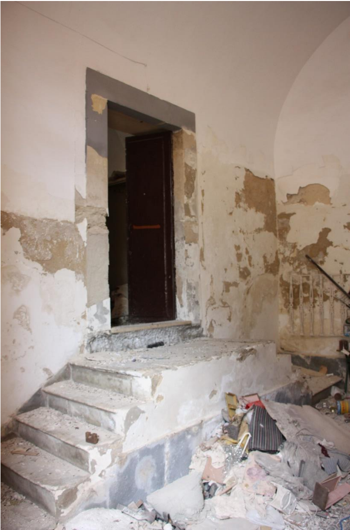
Figura 7 - Scale di accesso ai locali a piano rialzato
