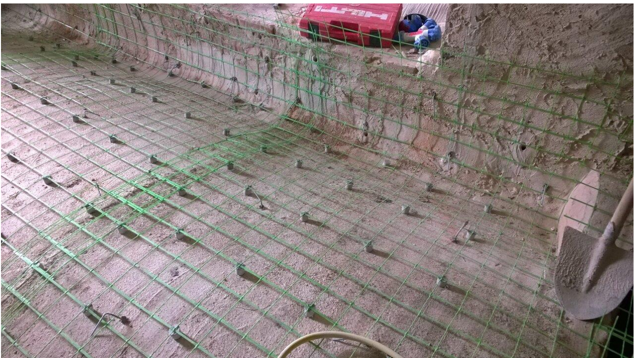
Figura 13 - Consolidamento all'estradosso delle volte a primo impalcato
