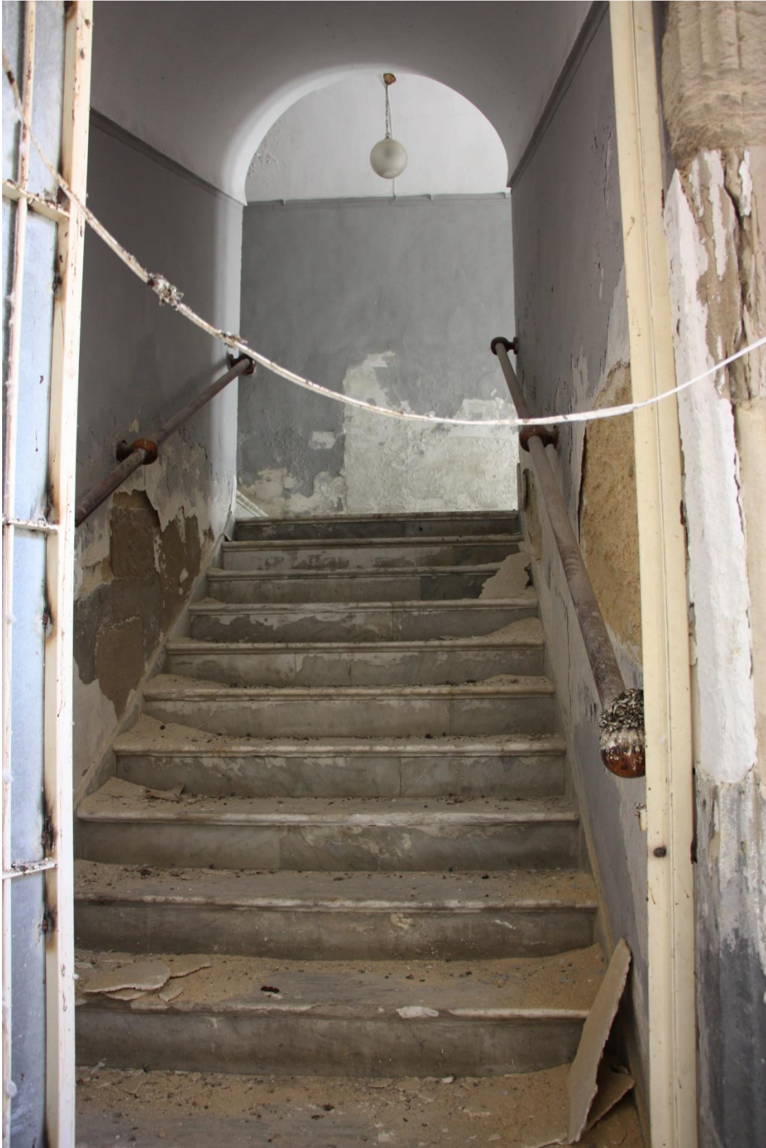
Figura 17 - Scale di accesso al Piano nobile del Palazzo
