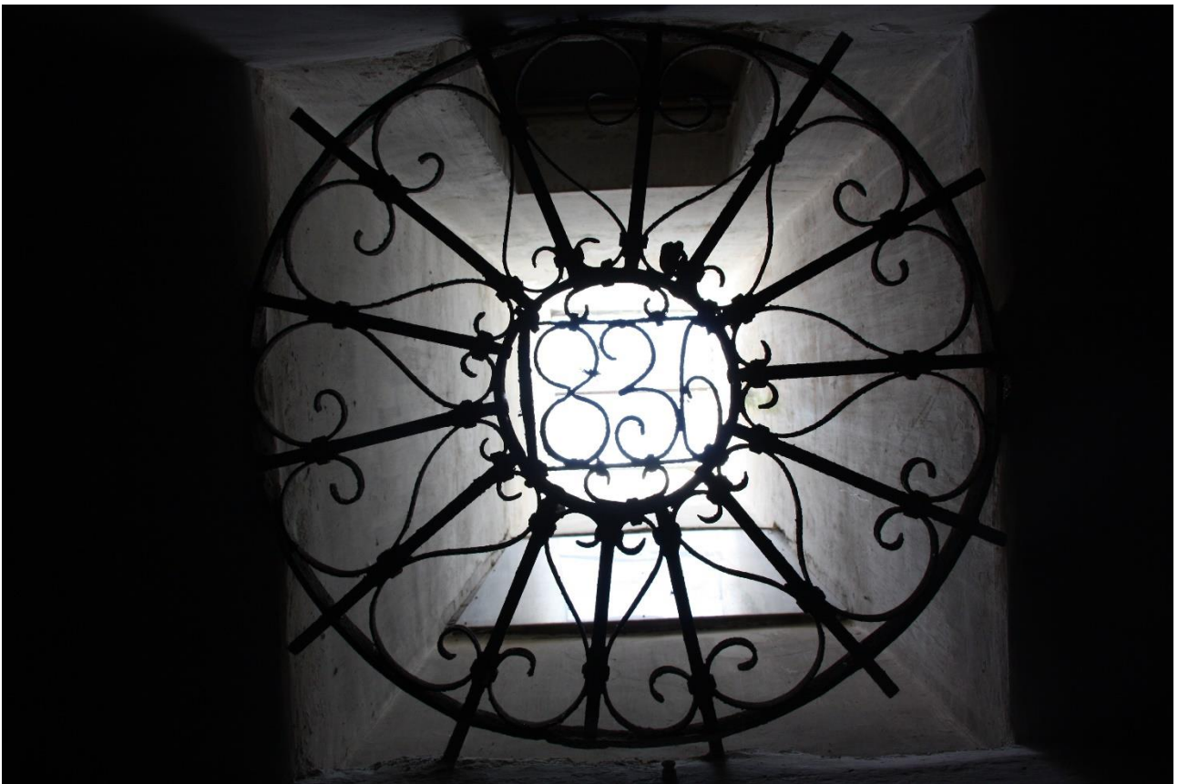
Figura 19 - Grata in ferro battuto del lucernaio sul pianerottolo d'arrivo al piano nobile
