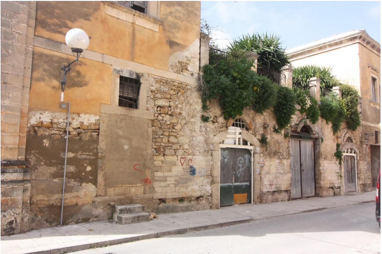
Figura 8 - Prospetto su Via Carlo Alberto
