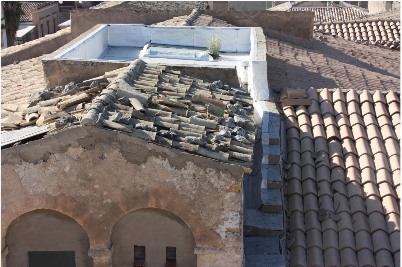
Figura 50 – Terrazzo sommitale raggiungibile da camminamento e displuvio laterale all'abbaino
