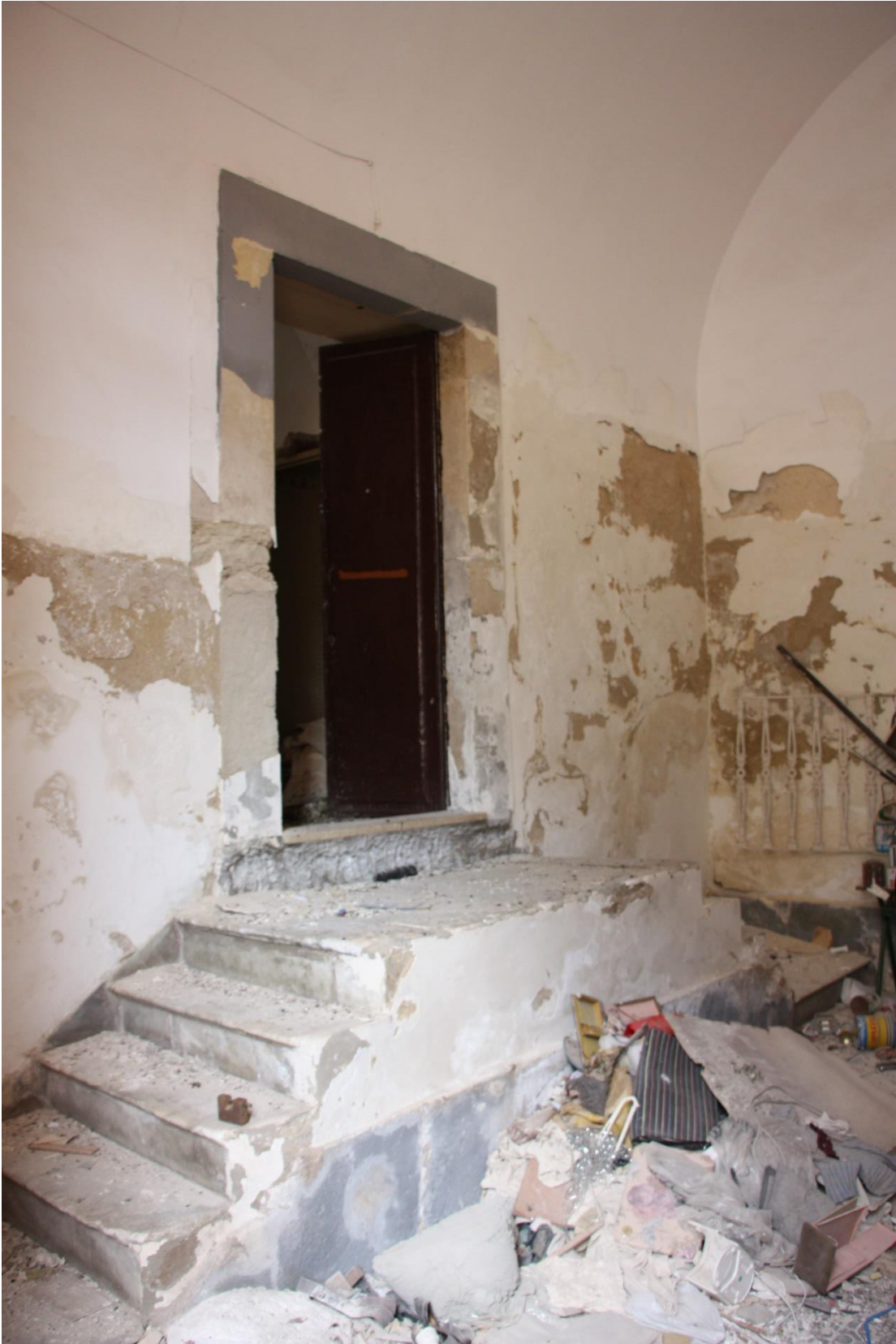
Figura 10 - Scale di accesso alle rimesse a piano rialzato dall'ingresso principale del Palazzo
