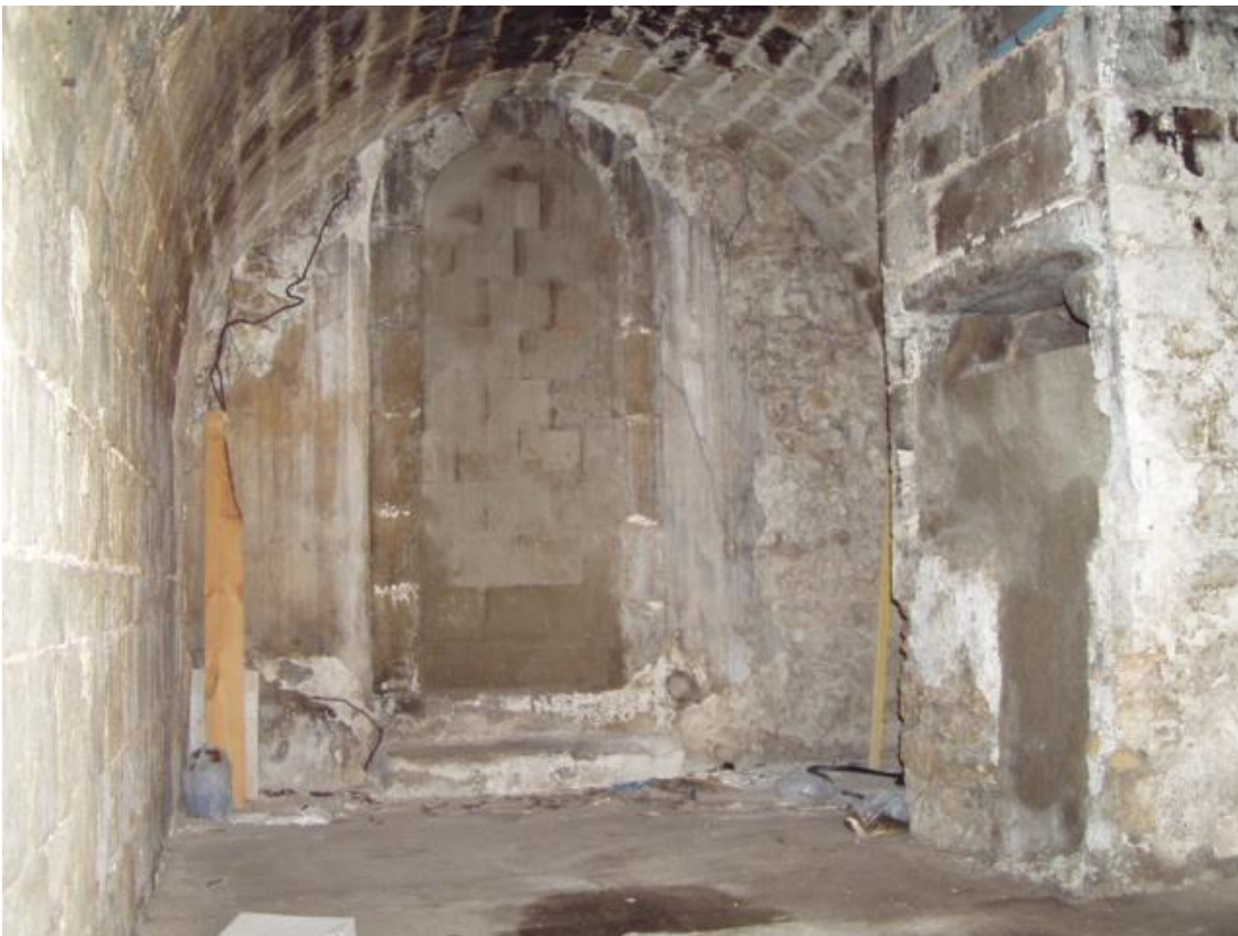
Figura 16 - Rimessa con accesso diretto da Via Carlo Alberto
