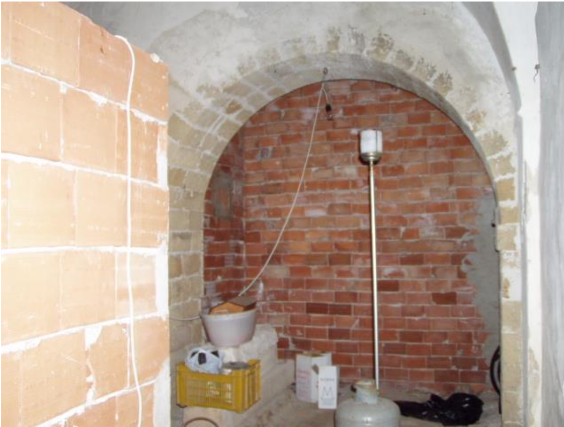
Figura 15 - Rimessa a piano rialzato con tramezzature e chiusure posticce
