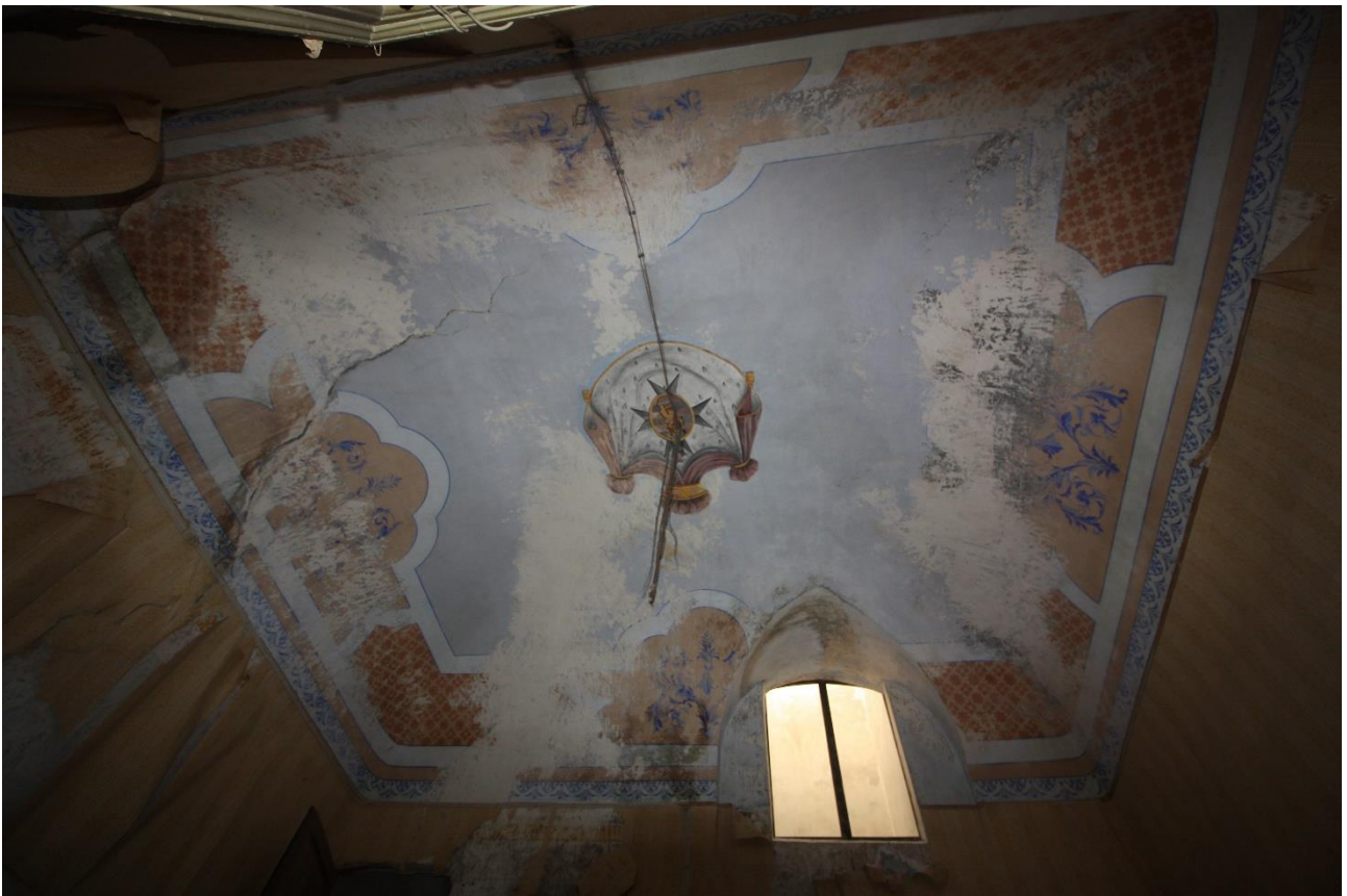
Figura 21 – Atrio di ingresso, decorazione a tempera della volta
