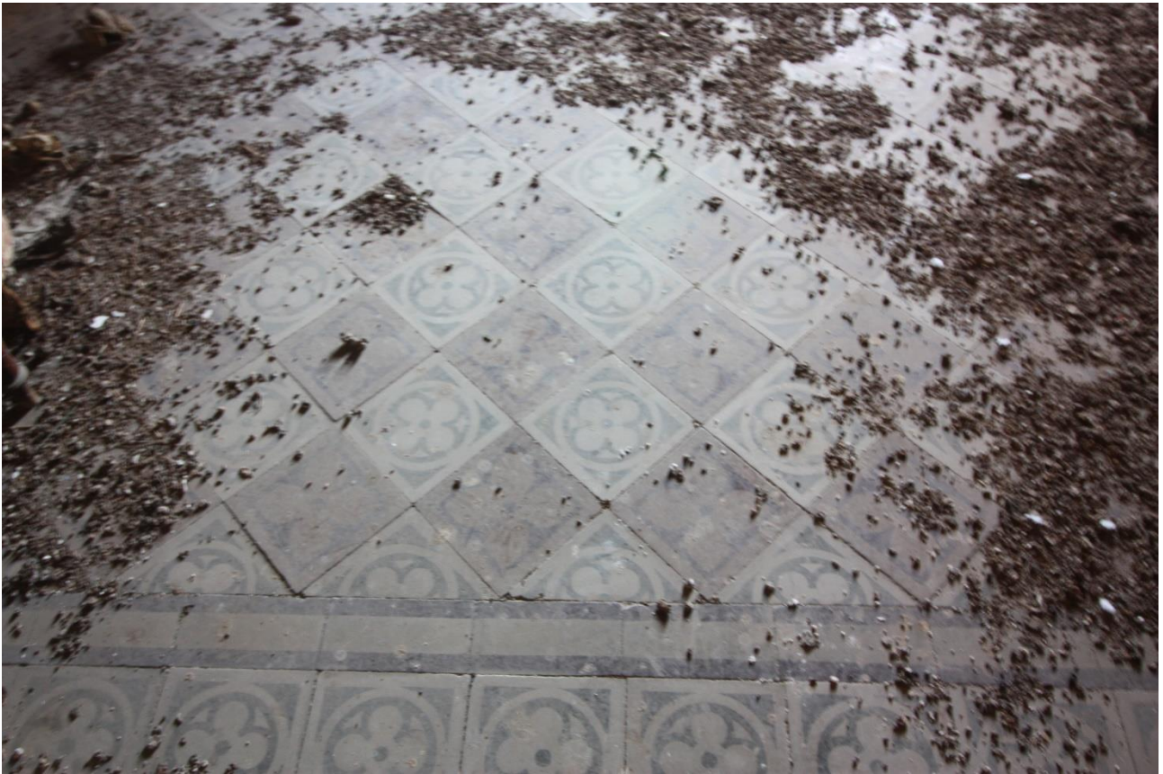
Figura 28 – Sala musica, scorcio della pavimentazione
