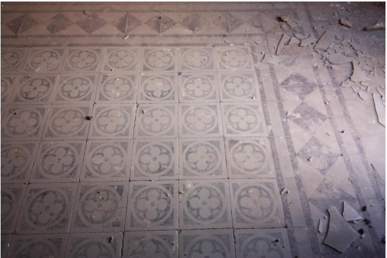
Figura 25 – Studio, scorcio della pavimentazione
