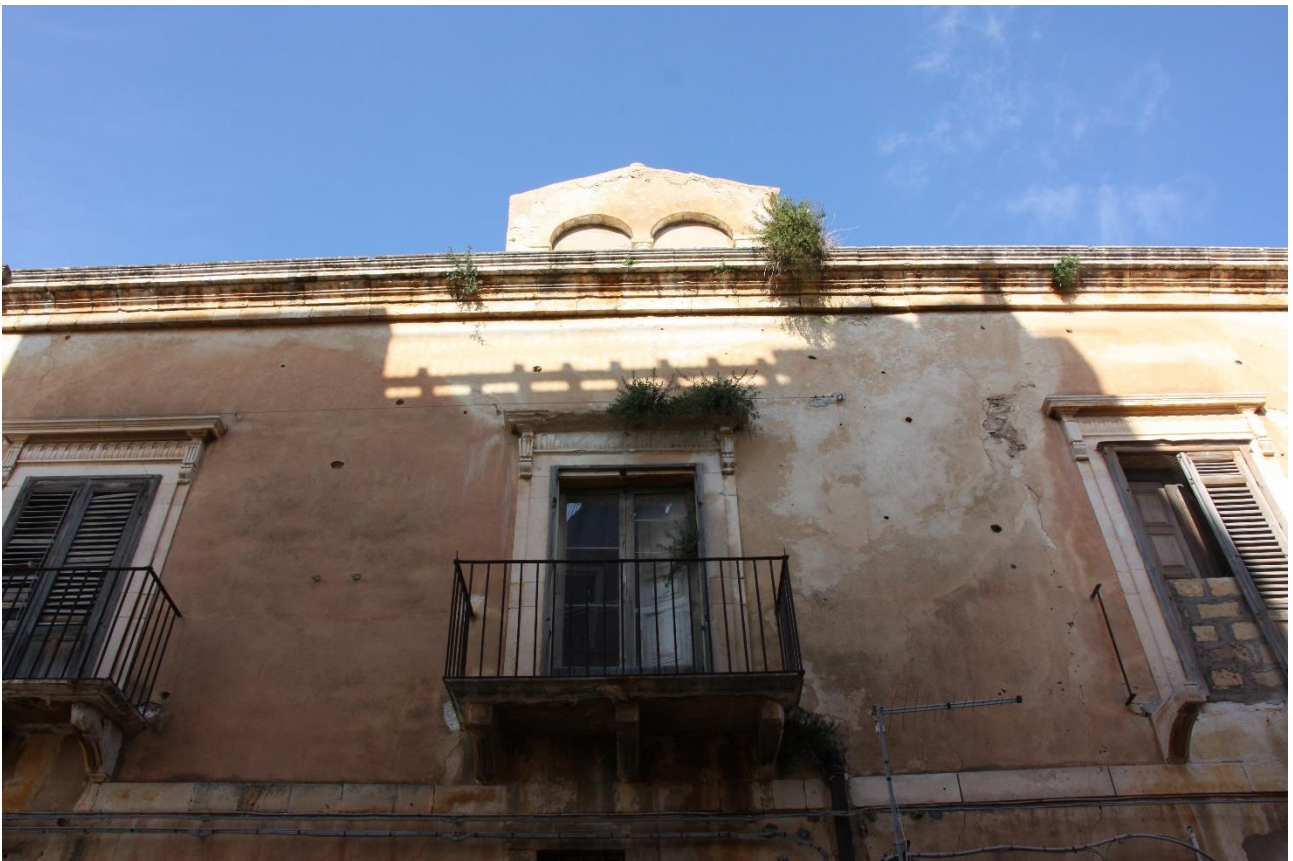
Figura 5 - Prospetto su Via Marsala con abbaino a piano copertura
