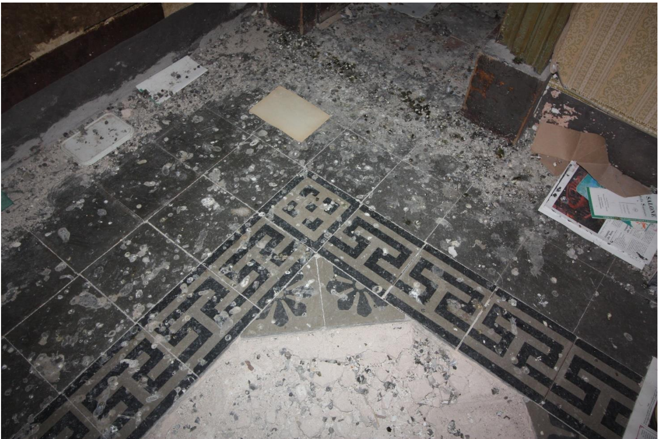
Figura 35 – Sala da The, scorcio della pavimentazione residua
