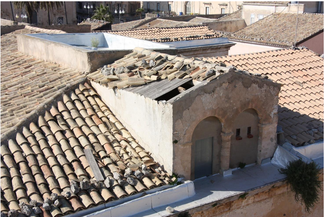
Figura 47 – Dettaglio dell'abbaino sulla copertura
