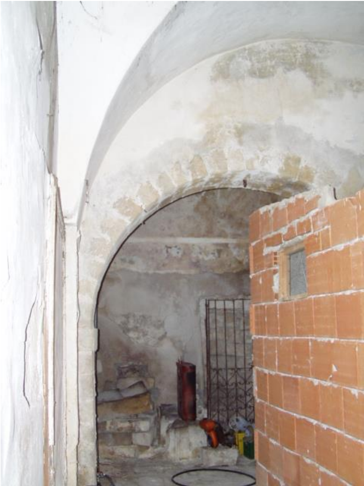
Figura 14 – Rimessa a piano rialzato con tramezzature posticce
