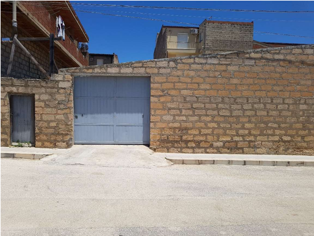
RILIEVO FOTOGRAFICO VISTA C
