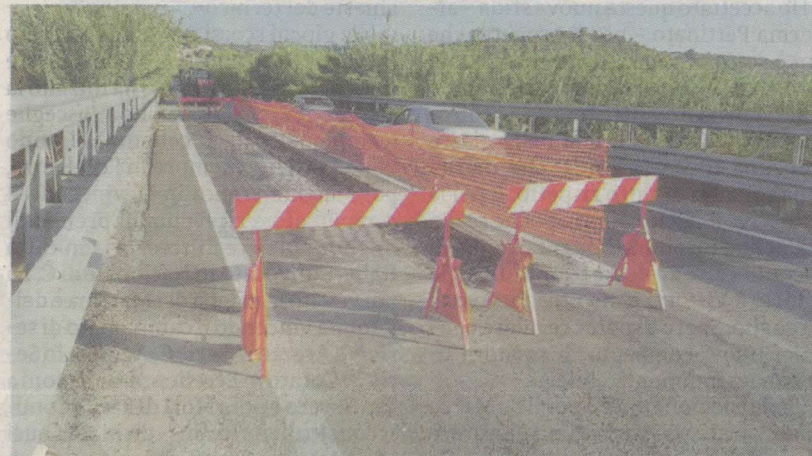
Il ponte sul fiume Ippari sulla provinciale 18
