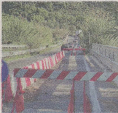
Il ponte sul fiume Ippari
