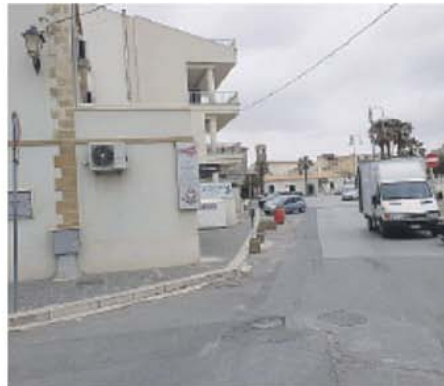
● Lavori a rilento sul lungomare
