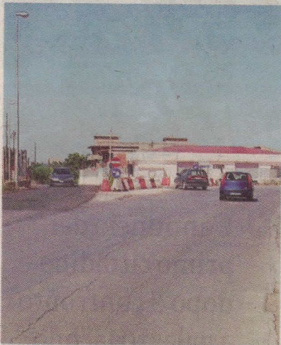
La rotatoria oggetto dell'intervento
