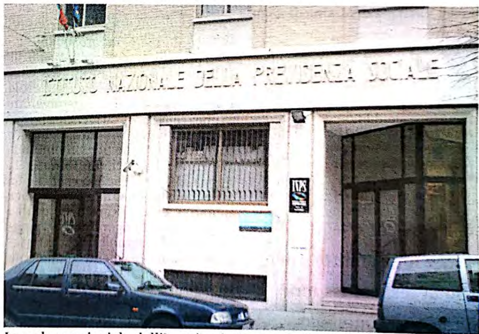
La sede provinciale dell'Inps in via Leonardo Da Vinci
