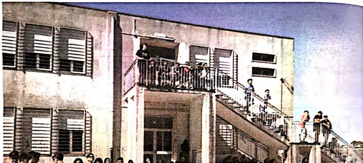
All'istituto Archimede di Modica sarà realizzata la copertura dell'ala nuova
