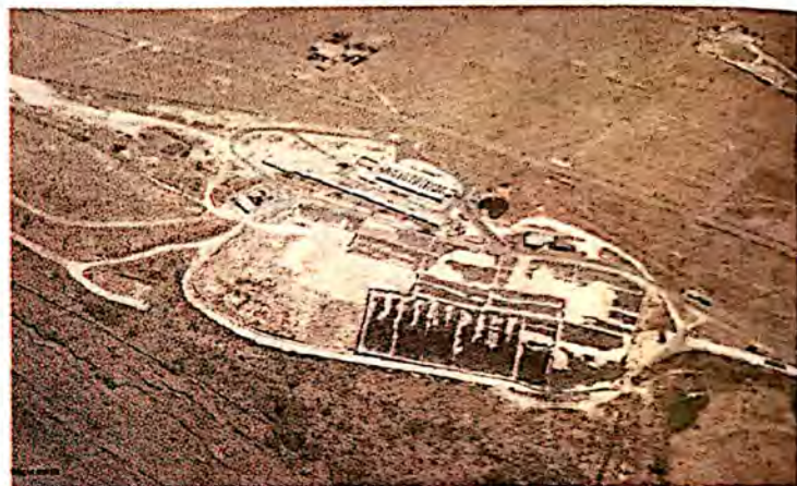
Una vista dall'alto della discarica di Cava dei modicani
