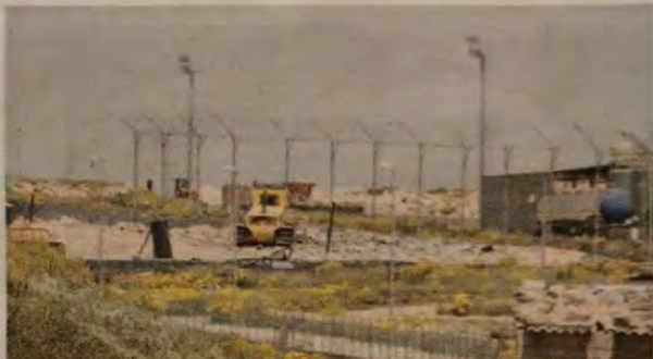
L'impianto di Cava dei modicani lungo la Sp Chiaramonte maltempo
