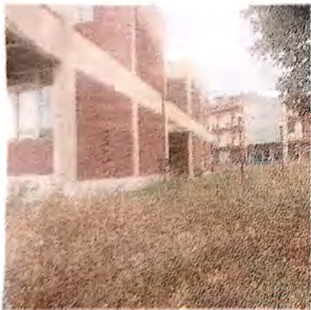
L'esterno della scuola Marconi
