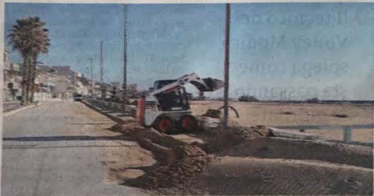
I lavori di rimozione della sabbia sul lungomare di Scoglitti
