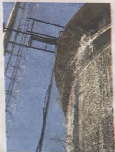
Uno dei serbatoi idrici cittadini
