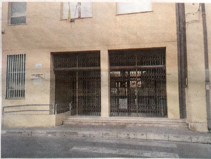
Il plesso elementare prima (in alto) e dopo (sopra) la denuncia di degrado
