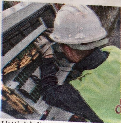
L'attività di cablaggio
