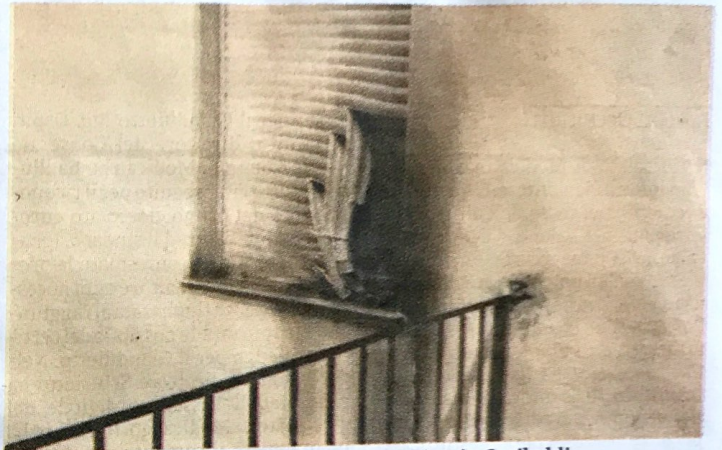
La finestra laterale della struttura situata in via Garibaldi
