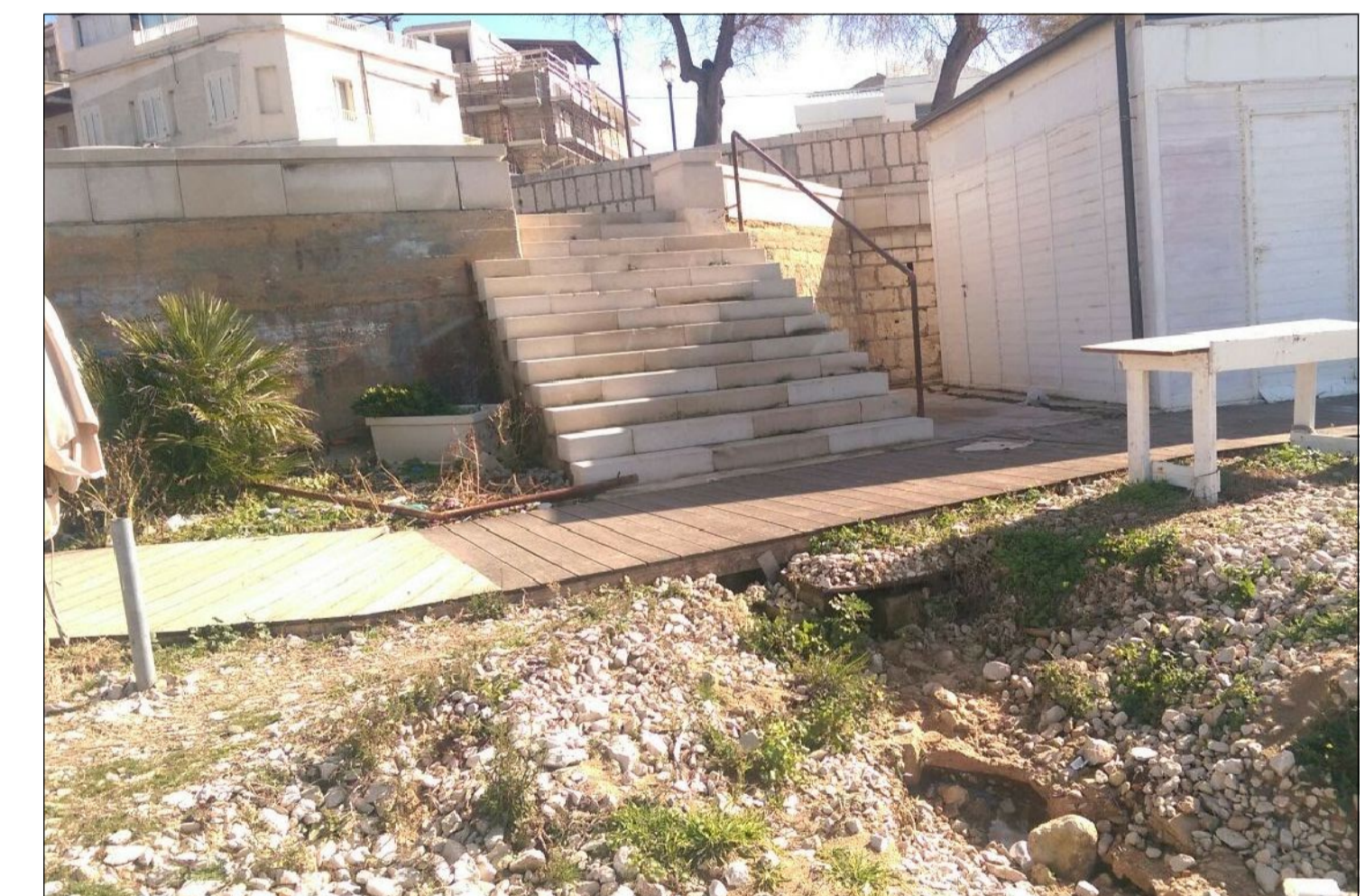
FOTO 3 _AREA DI INTERVENTO
