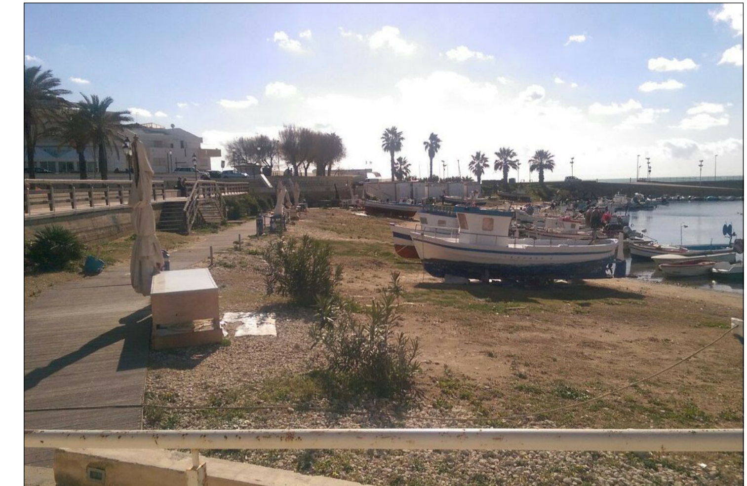
FOTO 2 _AREA DI INTERVENTO
