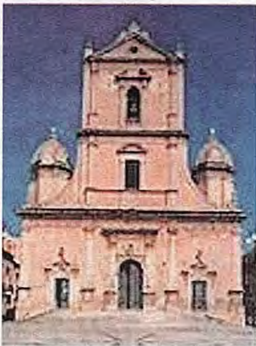
Il tempio. La chiesa di San Giovanni Battista che sarà oggetto di restauro
