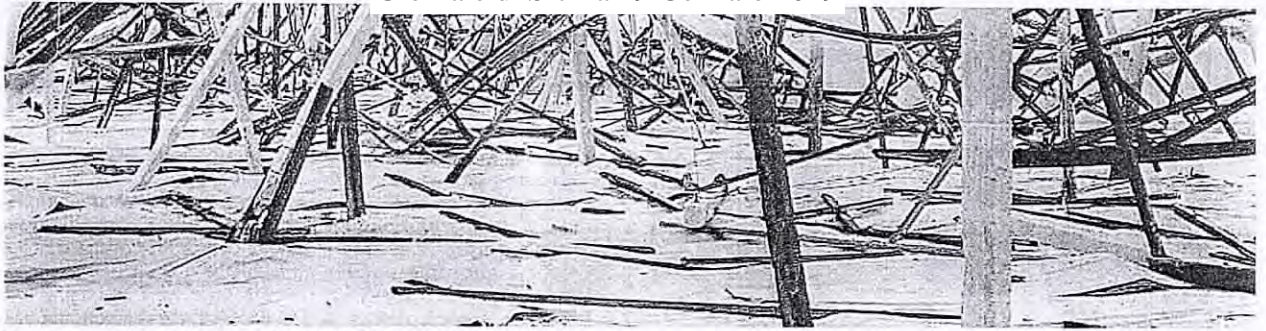
Il maltempo. I capannoni distrutti dalle furie del vento
