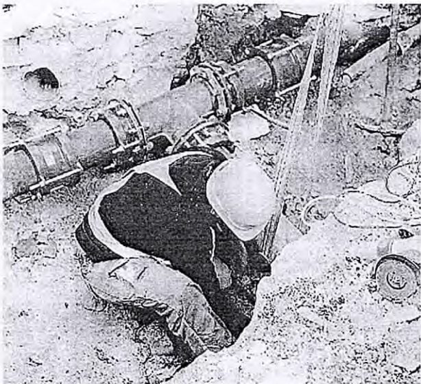
Acqua. Un operaio a lavoro per sistemare la condotta danneggiata
