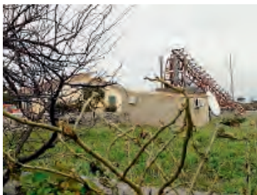
IL TRALICCIO CADUTO A MODICA
