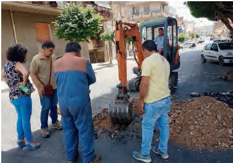
ALCUNI DEI LAVORI EFFETTUATI IN CITTÀ PER RIPARARE LA CONDOTTA DELLA RETE IDRICA
