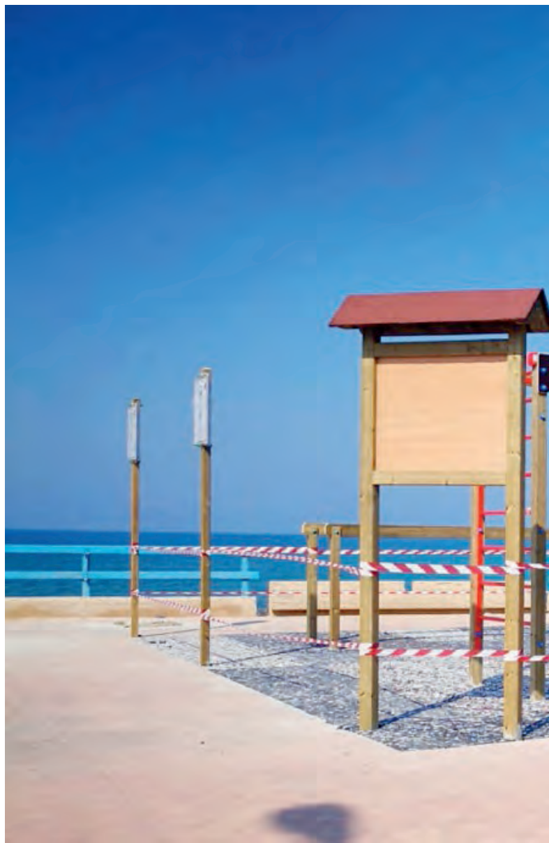
LA STRUTTURA CHE È STATA REALIZZATA ALL'ALTEZZA DI BAIJA DORICA
