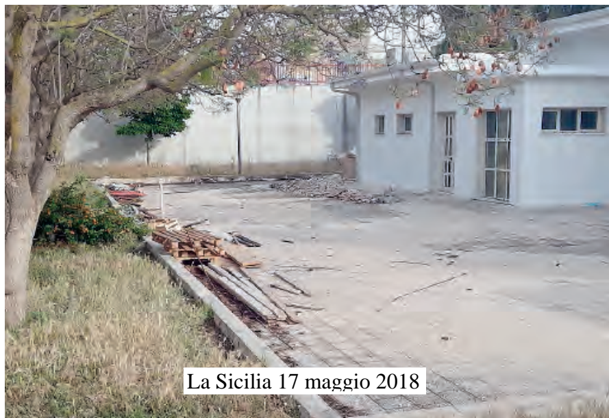
LA PARTE ESTERNA DELLA SCUOLA DELL'INFANZIA ALFREDINO FUSCHI
