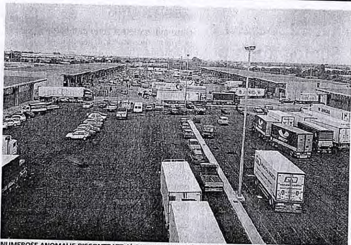
NUMEROSE ANOMALIE RISCONTRATE AL MERCATO ORTOFRUTTICOLO DI CONTRADA FANELLO
