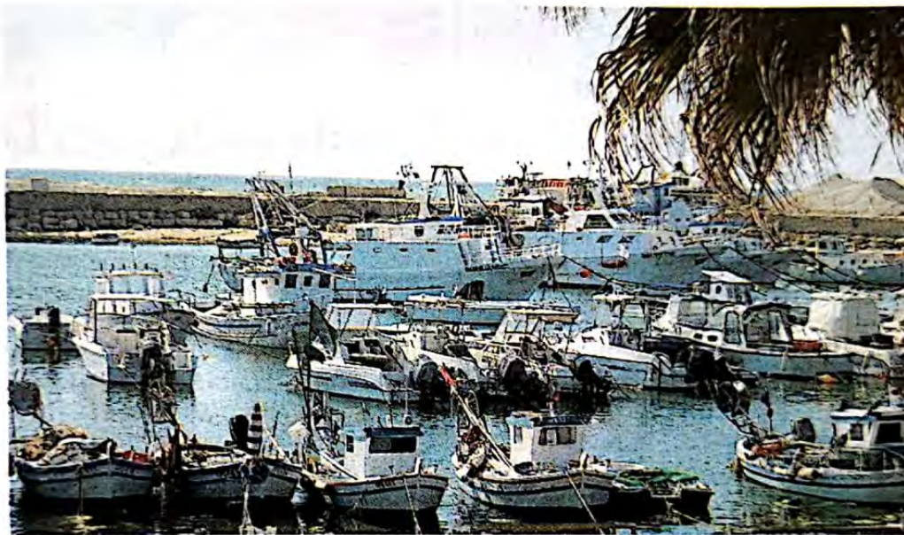
Il porto di Scoglitti destinatario di interventi non ancora concretizzati
