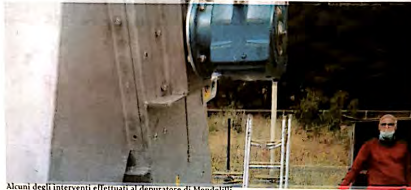
Alcuni degli interventi effettuati al depuratore di Mendolilli
