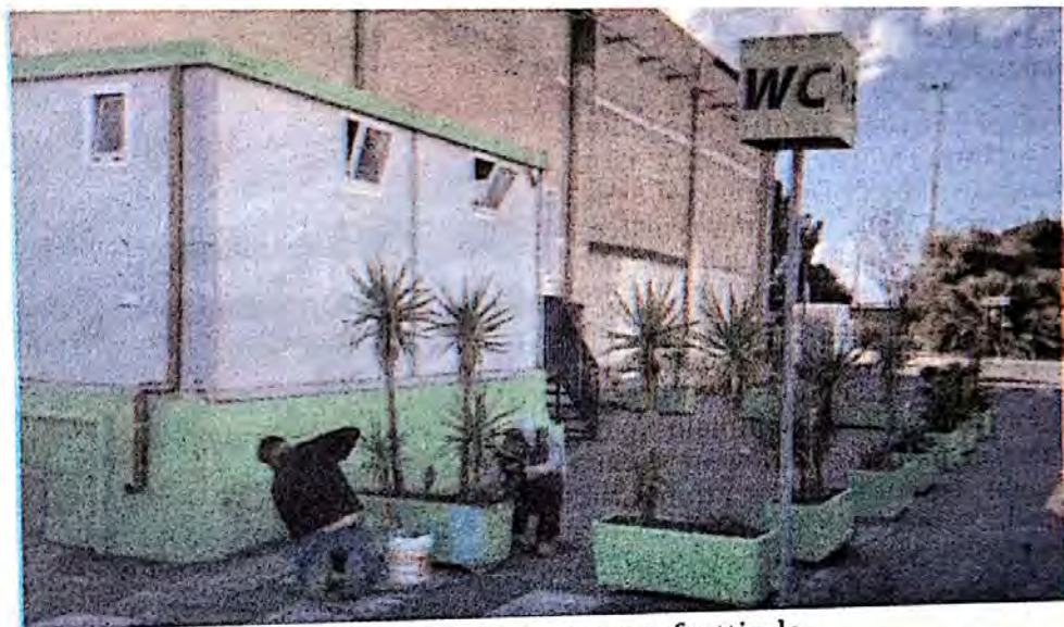
Il ripristino dei servizi igienici al mercato ortofrutticolo
