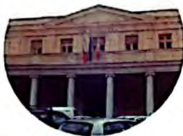
L'Asp. «Abbiamo verificato alcune problematiche da rodaggio ma già dalle 11 il sistema era funzionante».
