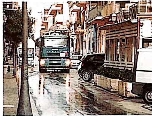
L'intervento per sanare l'anomalia esistente
