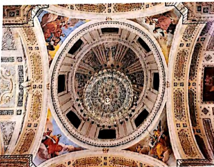
I lavori che hanno interessato il ripristino della cupola della basilica
