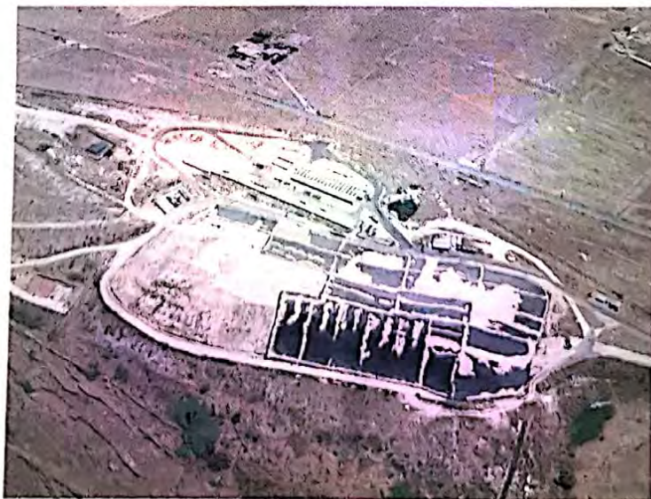
Cava dei modicani vista dall'alto e, sopra, cancelli ancora chiusi nel sito
