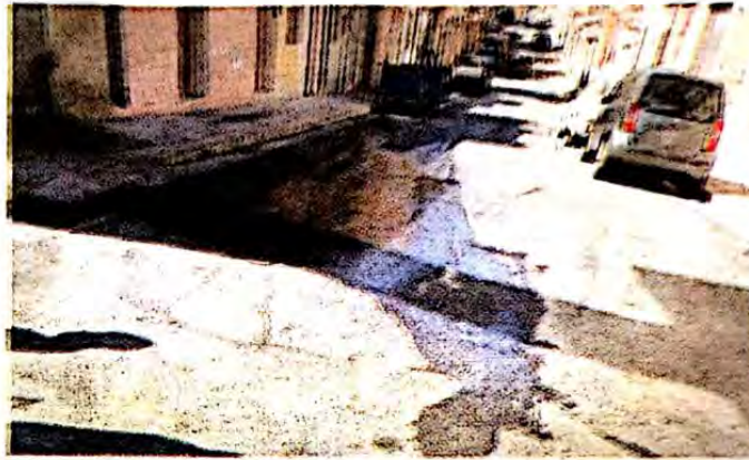
I liquami a cielo aperto in via Magenta
