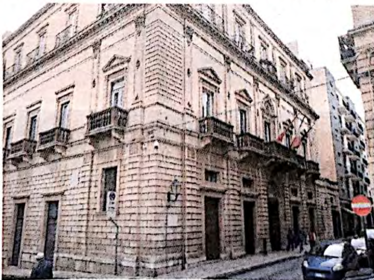
Il palazzo municipale e, nella foto sopra, la discarica di Cava dei modicani
