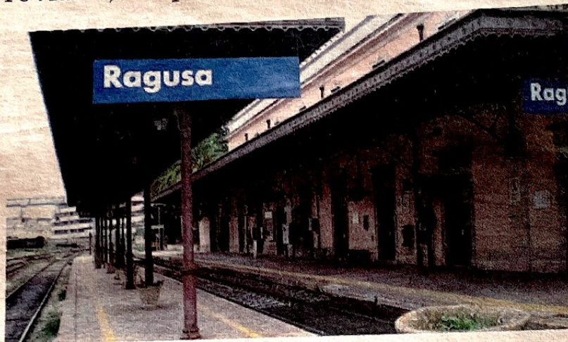
La stazione ferroviaria di Ragusa
