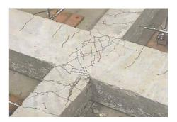
Nel caso in esame le tamponature non interferiscono col telaio in cemento armato, tuttavia il presidio dei nodi mediante applicazione di tessuti fibro-rinforzati produce un duplice vantaggio:
